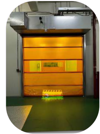
防火鐵捲門上方裝設感應投射燈
