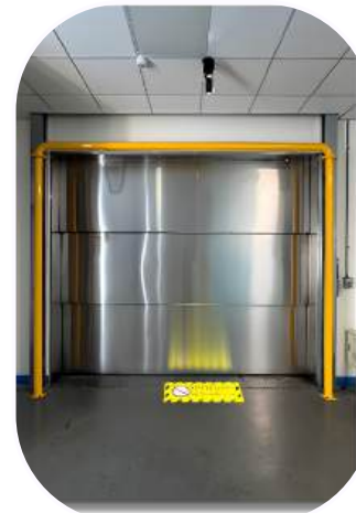
防火鐵捲門上方裝設感應投射燈
