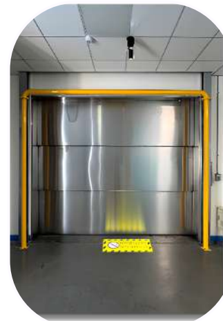
防火鐵捲門上方裝設感應投射燈
