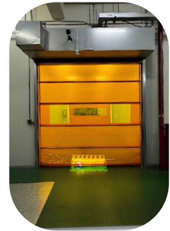
防火鐵捲門上方裝設感應投射燈
